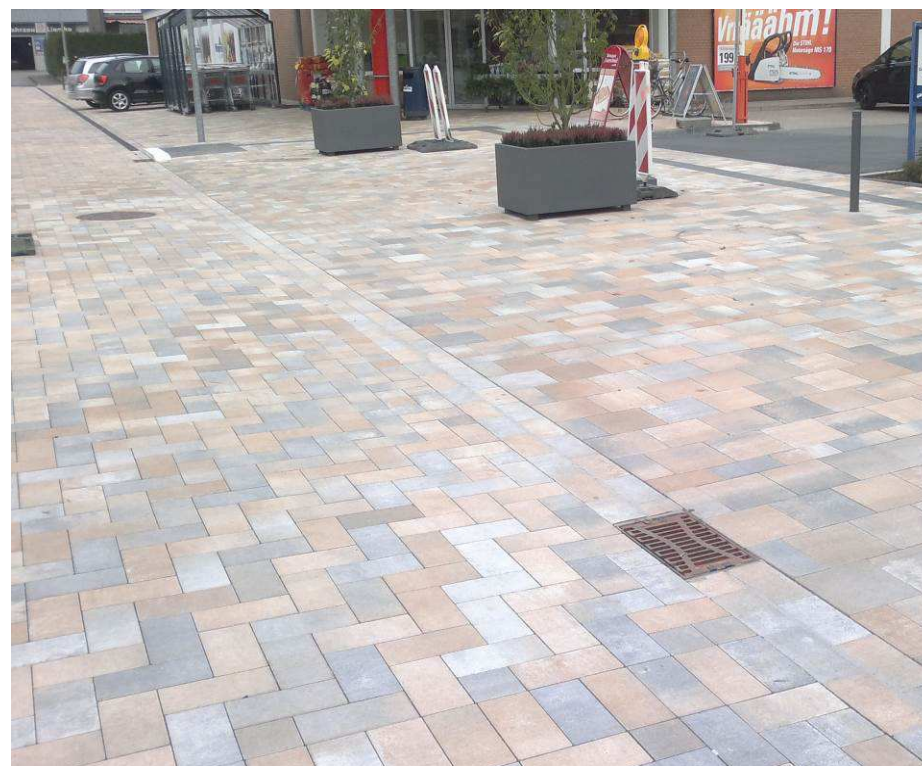
Straße Zur Post - Auflösung der Verkehrsflächen im jetzt verkehrsberuhigten Geschäftsbereich nach der Erneuerung
