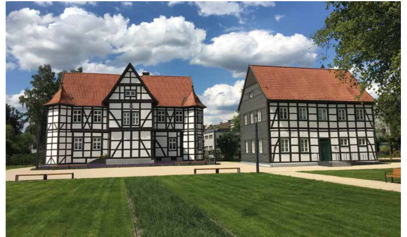
links: Jagdschloss nach der Sanierung
